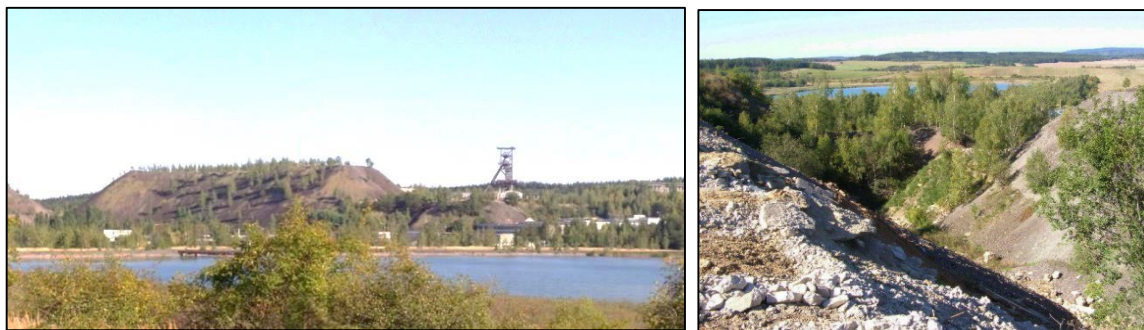
Obr. 184 Důl Bytíz - celkový pohled a propadlina po vypouštění základky na žíle Bt-4
