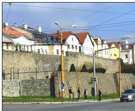
Obr. 142 Část městského opevnění
