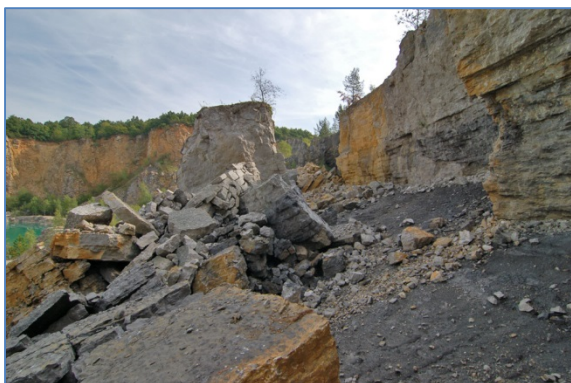
Obr. 18 Řícení stěn v lomu Homolák u Měňan
