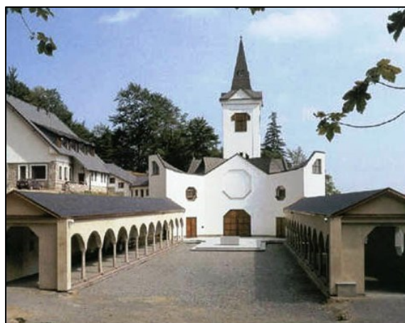
Obr. 203 Obnovená Kaple Panny Marie pomocné
